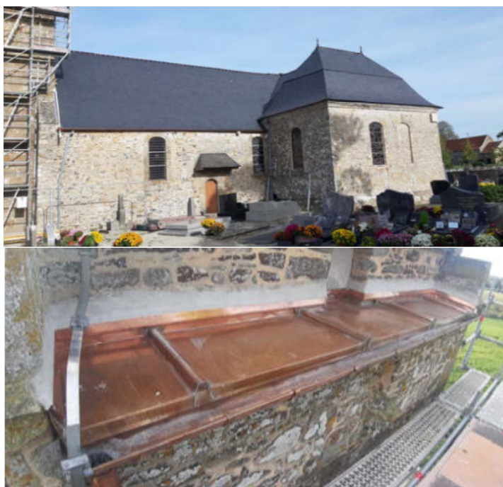
Entablement avec gouttière et descentes sous chaque versant du clocher
