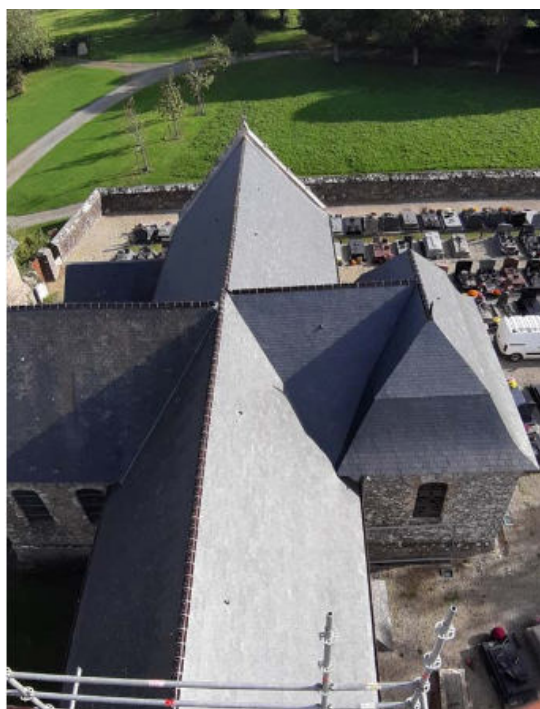
Reprises de charpente et réfection de la toiture en ardoises cloutées
