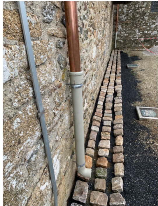
Le revers pavé en pied de mur en cours de finition
