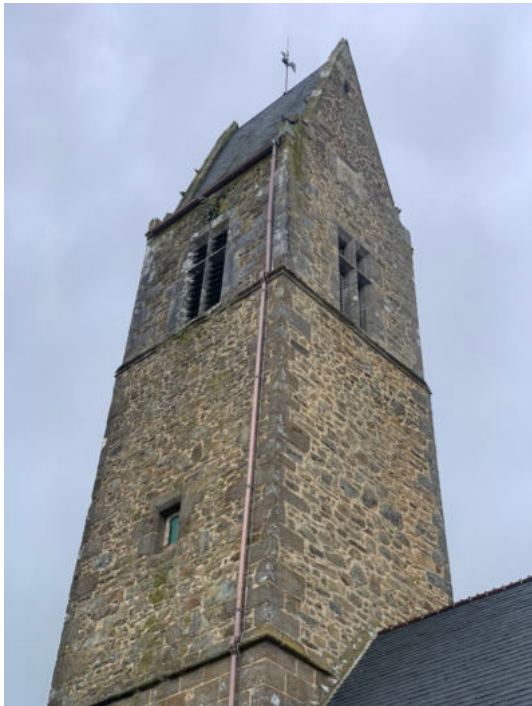
Le clocher et la nouvelle gouttière en cuivre
